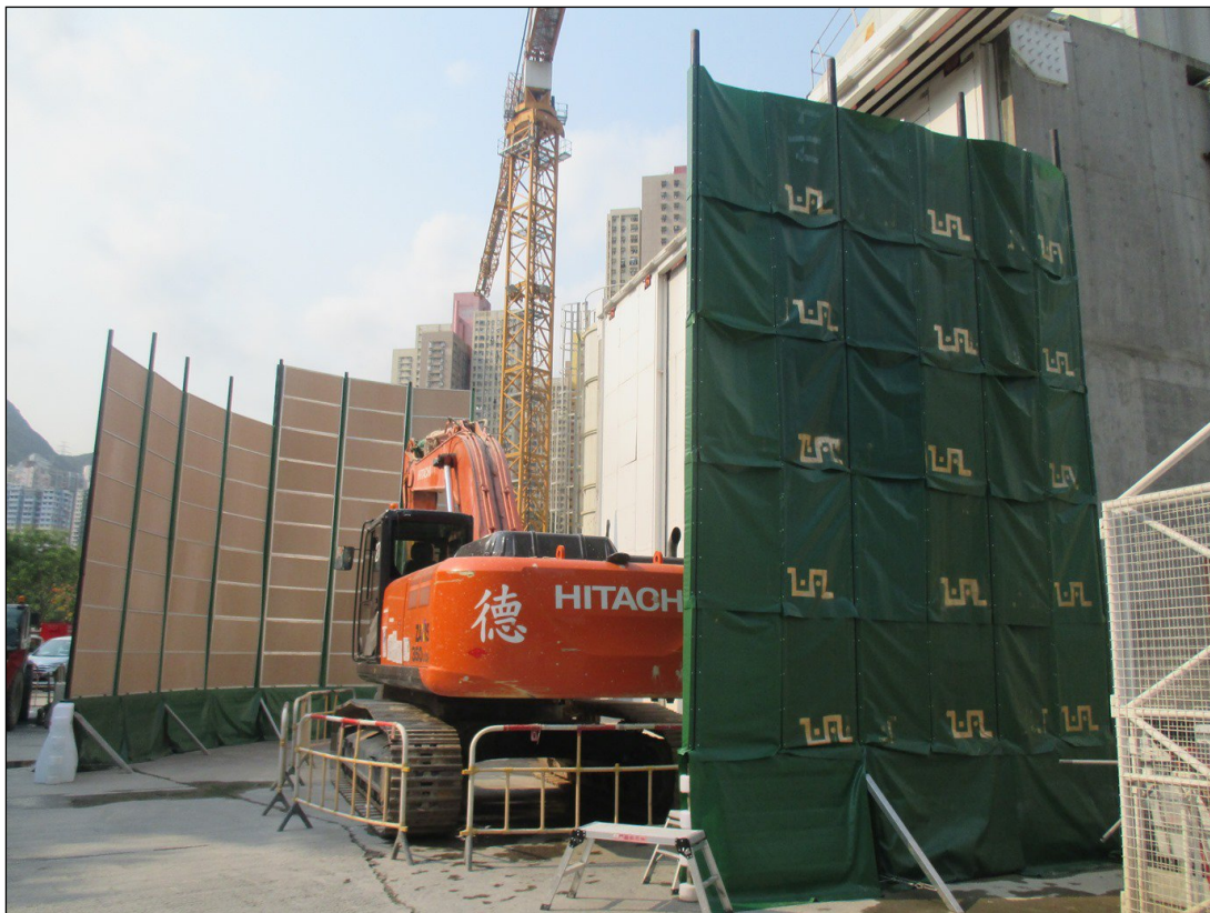
Εικόνα 9-2: : Χρήση ακουστικών ηχοπετασμάτων γύρω από την περιοχή όπου πραγματοποιούνται εργασίες που προκαλούν υψηλά επίπεδα θορύβου
