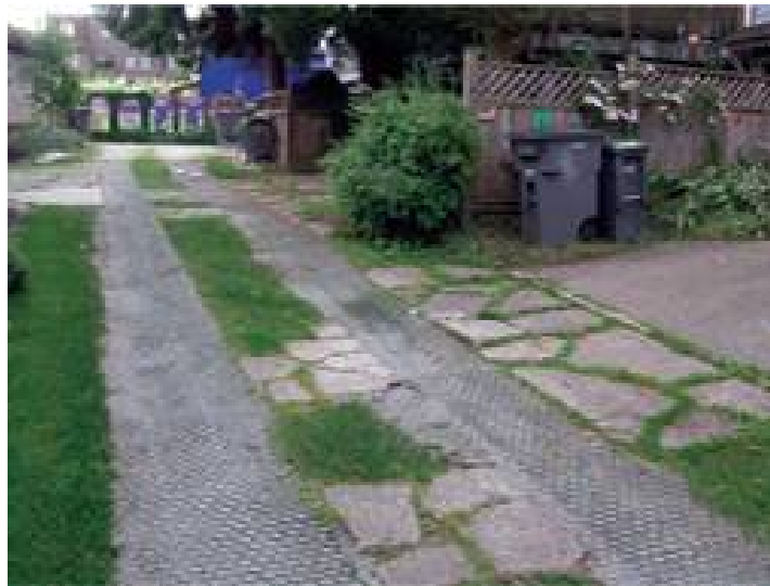
Εικόνα 9-11: Απορροφητικά πεζοδρόμια [Πηγή: New York State Stormwater Design Manual, August 2003]
