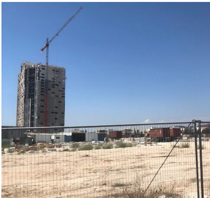
Εικόνα 5-1: Κτίριο υπό ανέγερση δυτικά των τεμαχίων του ΠΕ
