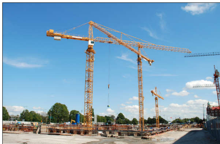
Εικόνα 6-8: Γερανός σταθερής βάσης (tower crane)
